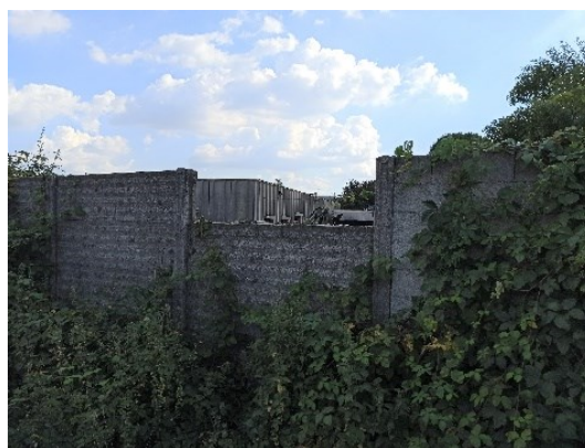
Vista verso Sud, all'interno del muro di cinta
